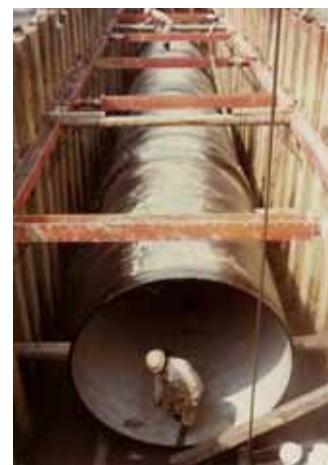
耐震型緊急用貯水槽設置工事
