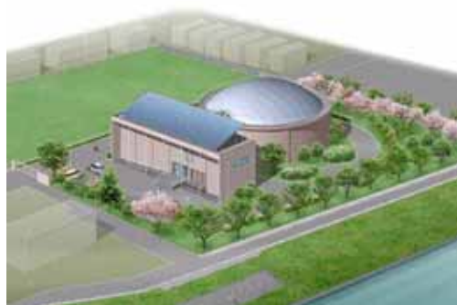
太陽光発電（定格出力 55kw/h）
