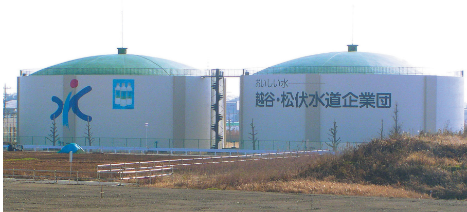
JR武蔵野線・越谷レイクタウン駅近くの東部配水場。春にまちなみになる越谷レイクタウンの景観に配慮し外壁塗装したこの施設は、1日26,000m³の水を供給可能で、新しいまちの配水拠点となる。
