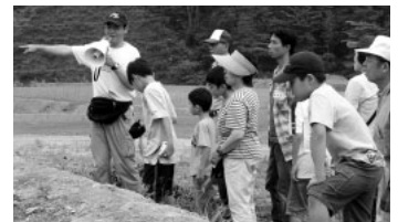
ダム建設現場を見学する参加者
