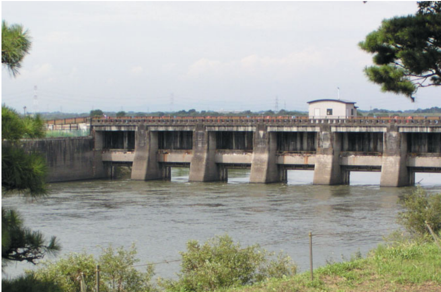
利根川と江戸川の分岐点近くにある関宿水門。 わたしたちの水道水のもととなる江戸川の流量を調節している。
