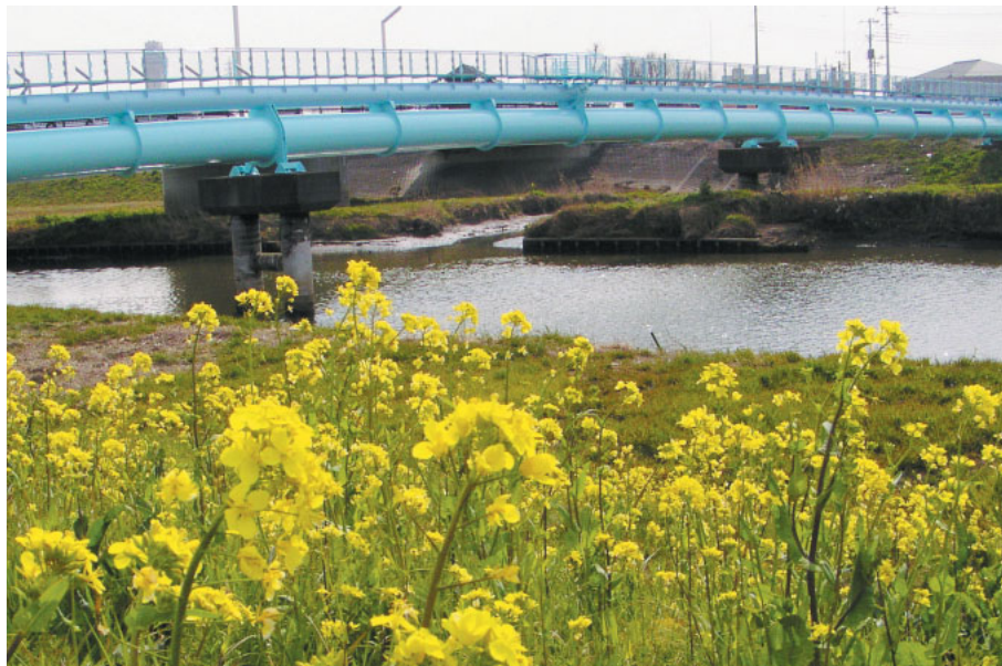
古利根川のふれあい橋北側に架かる水管橋。築比地浄水場から松伏町を通過して越谷市内に水を送る管(上)と、県営庄和浄水場から県水(用水)を送水する管(下)の2つが一体となっている。
