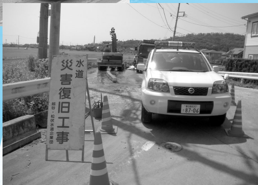
7日間にわたり漏水調査・修繕を行いました
