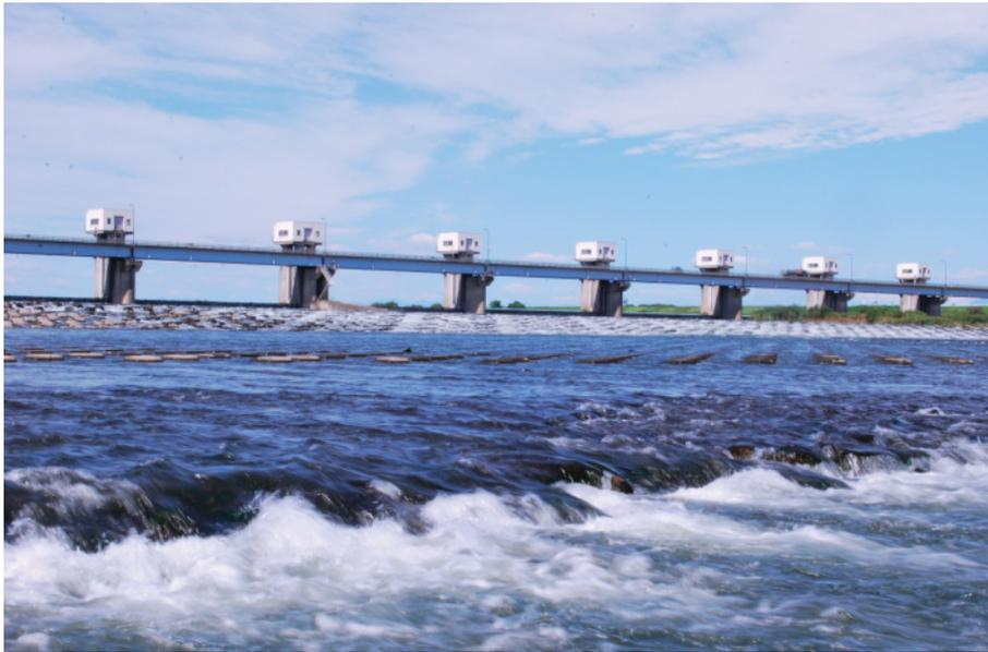
利根川中流の利根大堰。わたしたちが利用する利根川水系の水を武蔵水路を通じて荒川水系に送るための施設
