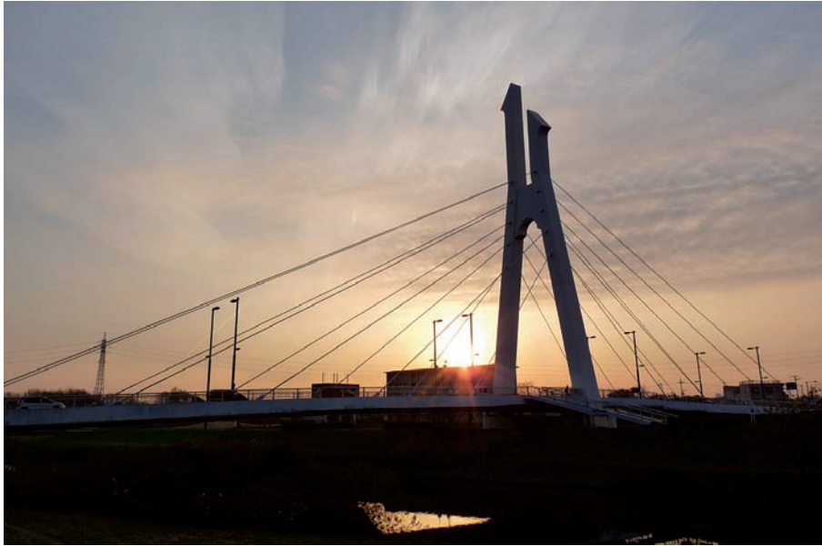
朝日に照らされるしらこぼと橋。元荒川と葛西用水の合流地点に架かり、「水郷こしがや」を代表する景観のひとつとなっている。
