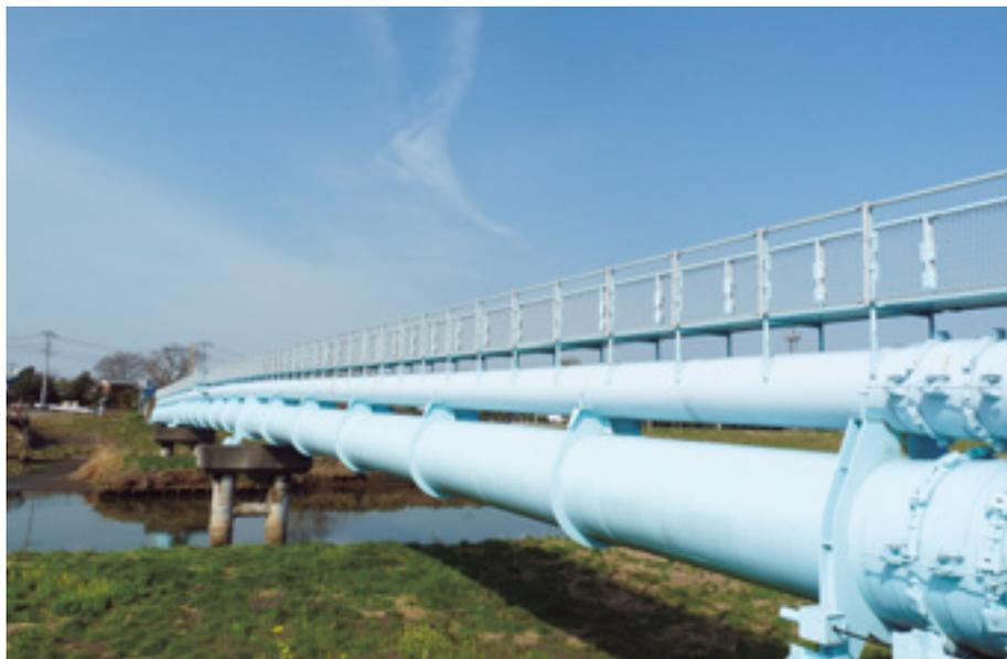
大落古利根川・ふれあい橋北側に架かる水管橋。松伏町にある築比地浄水場から越谷市内に水を送る管(上)と、県営庄和浄水場から水を送る管(下)の2つの管が架かっている。
