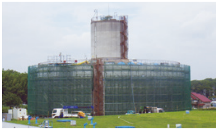
PC配水池 耐震補強工事状況
