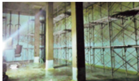
RC配水池 耐震補強工事状況
