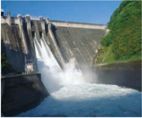
▲下久保ダム (独)水資源機構下久保ダム管理所提供
