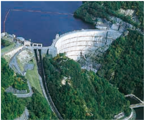
▲矢木沢ダム (独)水資源機構沼田総合管理所提供
