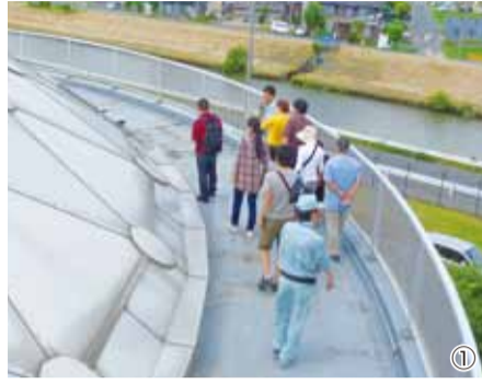
① 配水場屋上にあるアルミドームや太陽光パネル、ポンプ室など、普段は見られない施設をご案内
