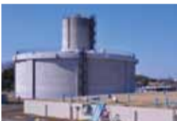
耐震化が完了した築比地浄水場
