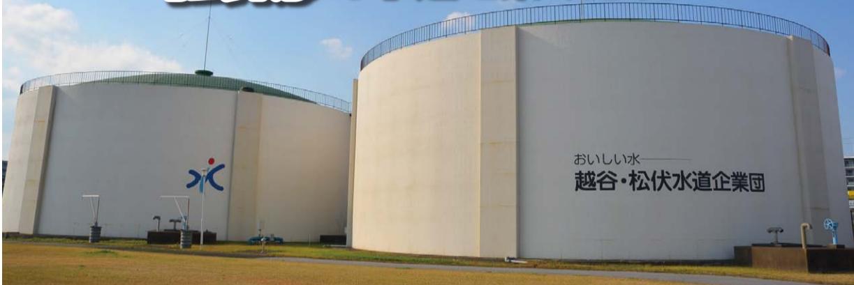
東部配水場のPC配水池
