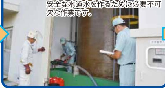
浄水場では、次亜塩素酸ナトリウムという消毒剤の補充を行います。安心・安全な水道水を作るために必要不可欠な作業です。
