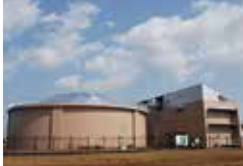
耐震工事後の北部配水場
