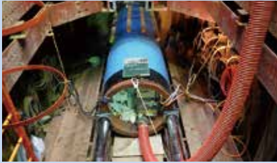
築比地浄水場系の基幹管路の更新
