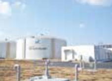
耐震工事後の東部配水場
