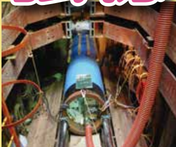
築比地浄水場系基幹管路の 更新工事
