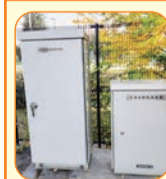
末端水質監視装置 24時間365日水質を監視しています
