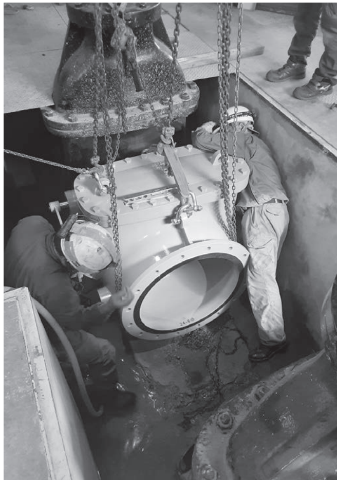
築比地浄水場 逆止弁更新工事 (令和6年(2024年)8月)
