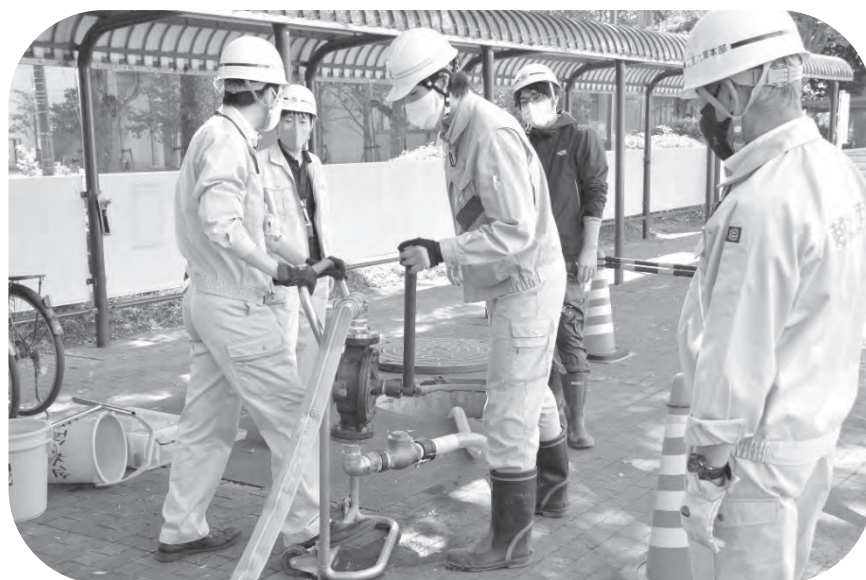
耐震型緊急用貯水槽を用いた応急給水訓練 (令和2年(2020年)10月)
